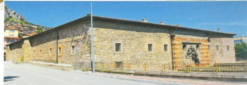
Yapının güneydoğu cephesi / Southeast façade of the structure
